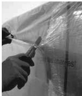
2 Ecarter le film plastique de protection et le découper au cutter. S'assurer que la lame n'entre pas en contact avec les panneaux pour ne pas les endommager.
